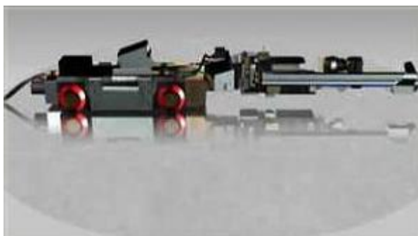
Krok 5A Robot instaluje kabel światłowodowy.
