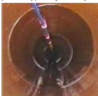
Krok 6 Po instalacji kabla rura wygląda tak.
